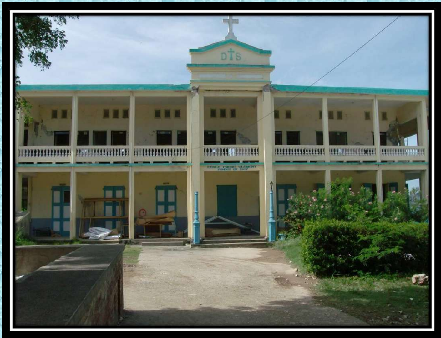
Ecole des Frères de l'Instruction Chrétienne sur le site de la Petite Batterie, Jacmel 2009. Cet immeuble s'effondra pendant le séisme du 12 janvier 2010
