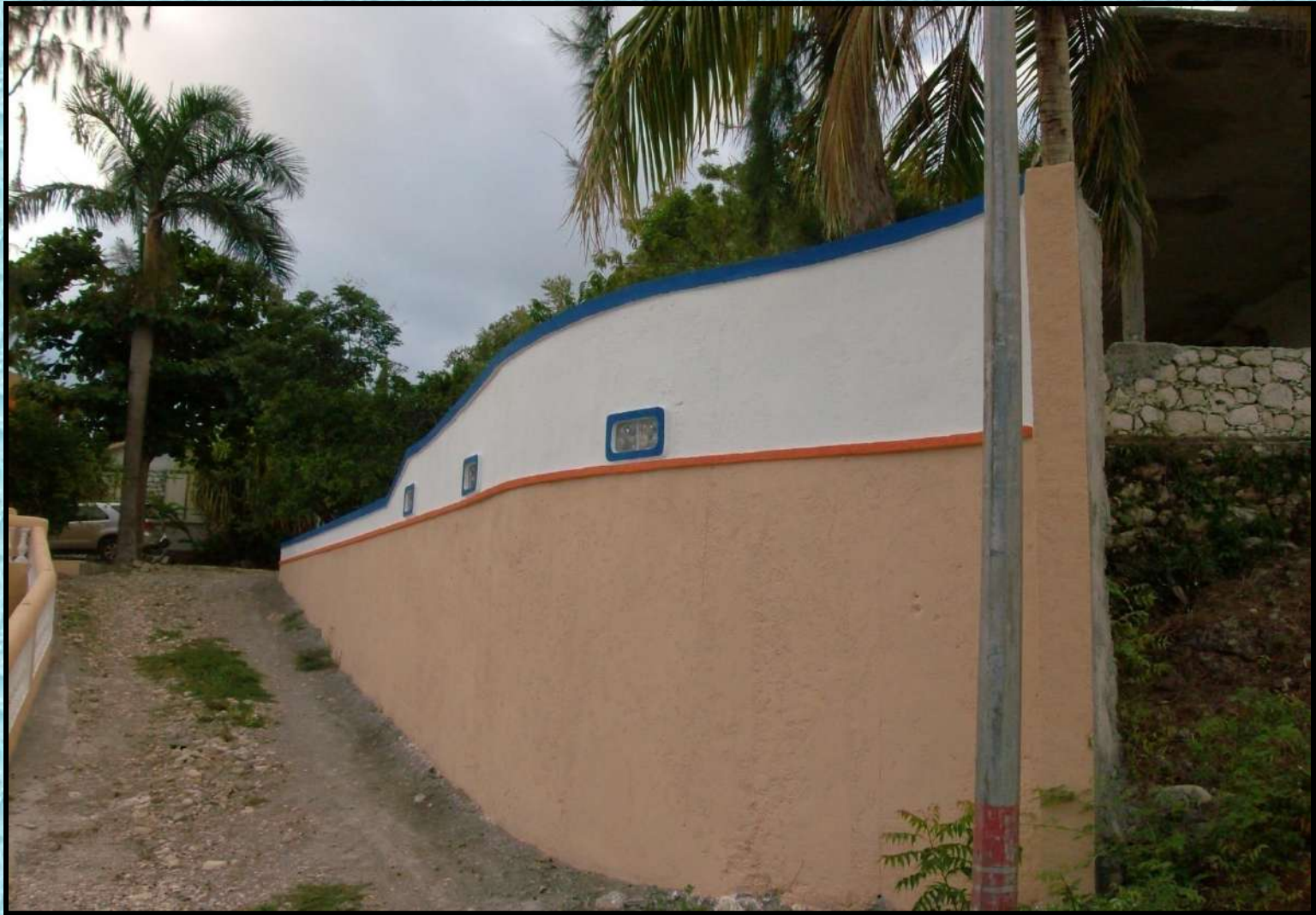
Un mur mitoyen en forme de bateau, création de l'ingénieur Carmeleau Pierre-Louis
